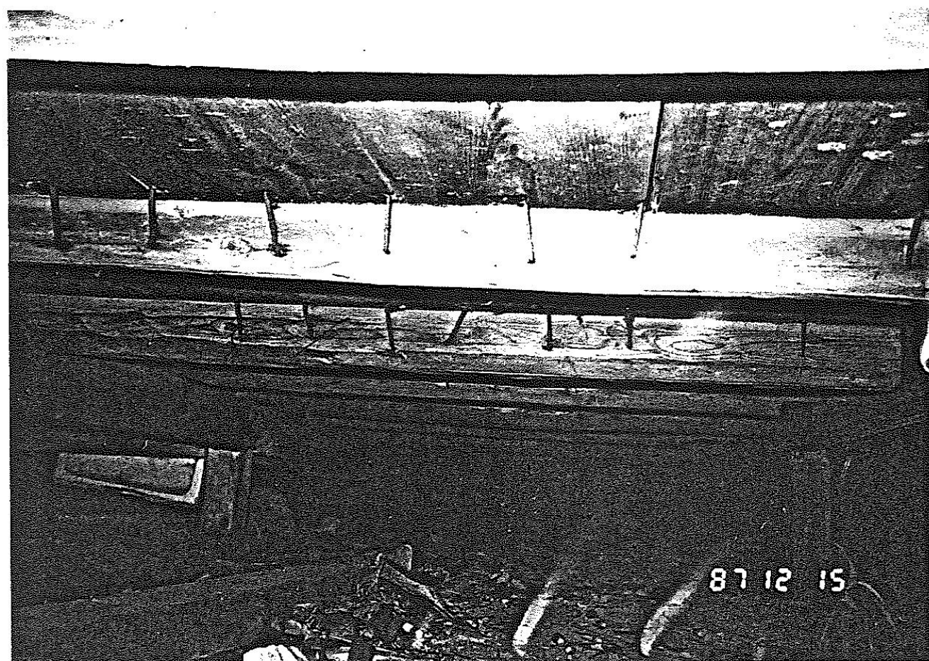
渡り廊下、床下 床板と根太の カスガイ止め
