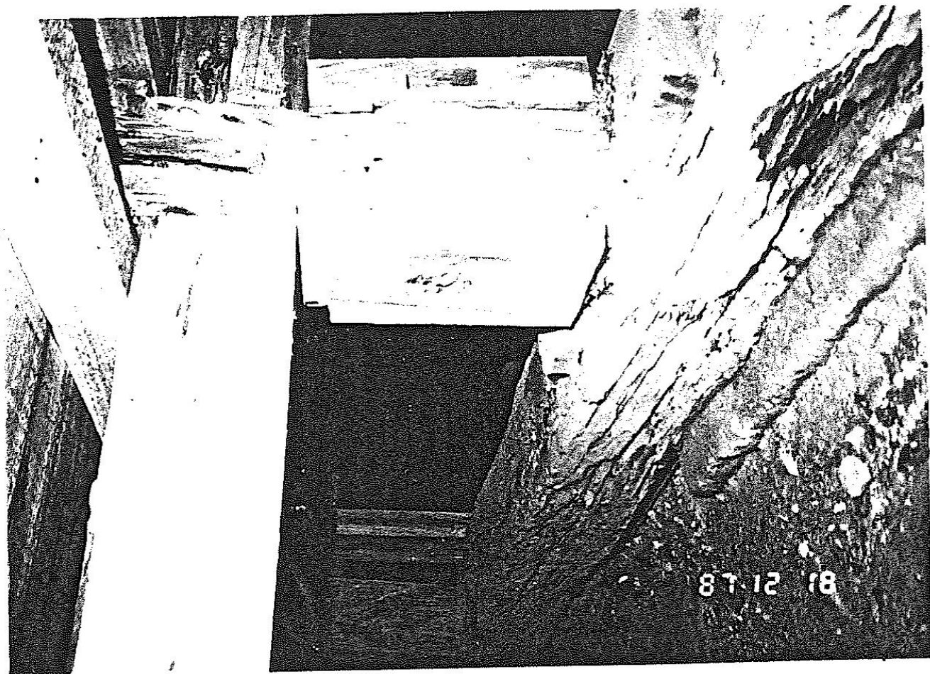
8 星溪寮 土台の腐朽.
