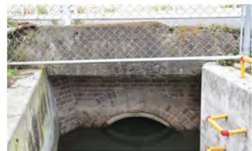
村岡樋管は、吉見用水が万吉地区から村岡地区に流入する位置にあります。この樋管は用水出口などに造られる構造物を意味するもので、明治23年(1890年)8月の洪水によって大破した木造の旧施設(用水口)を、明治24年(1891年)煉瓦造りでアーチ状のトンネル様式として改良建設したものです。
