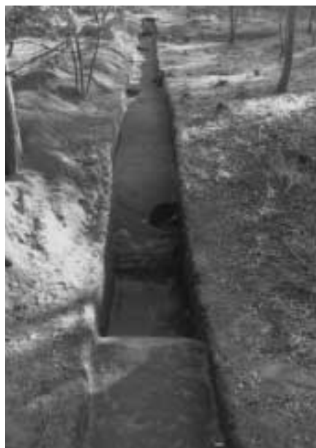
▲第6トレンチ 堀完掘状況
