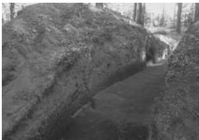
▲第4トレンチ 北側土塁土層堆積状況
