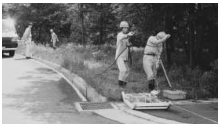
◀D調査区調査状況
