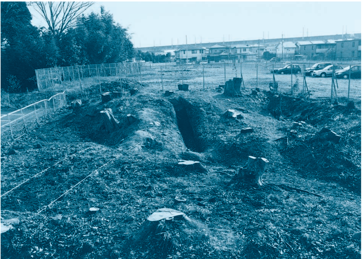
2 調査前全景（北から）
