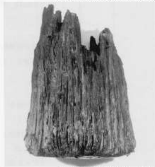
第8号掘立柱建物跡ビット4柱痕
