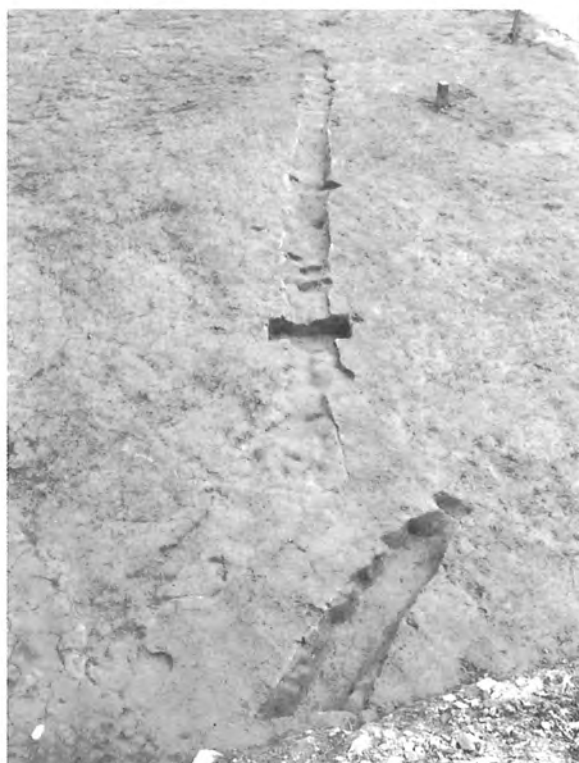
第4・5号溝跡（北西から）
