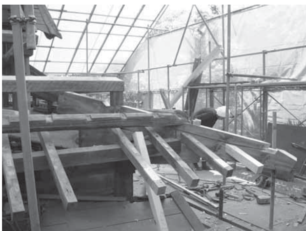
59 隅木廻り修理
