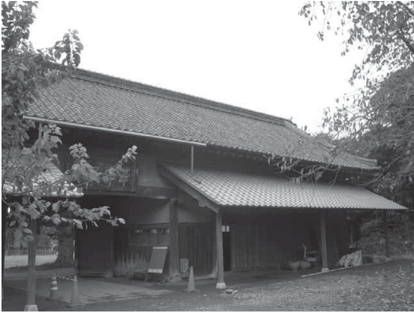
4 竣工 背面西側写真
