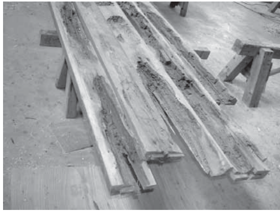
26 裏甲腐朽状況
