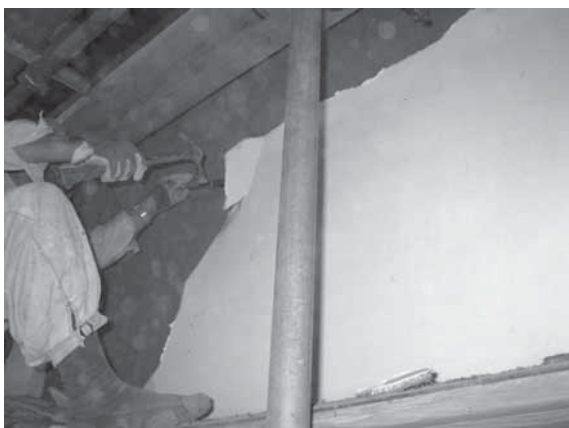
116 既存喰壁掻き落し
