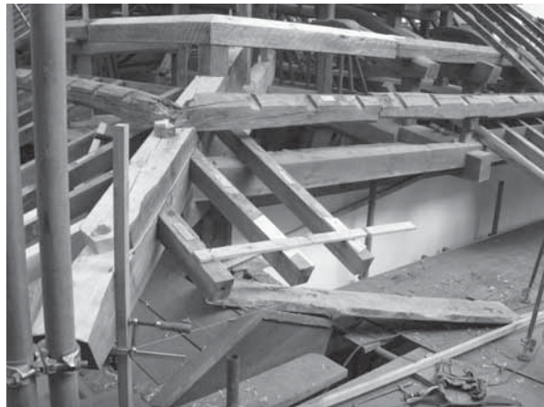
60 隅木廻り修理
