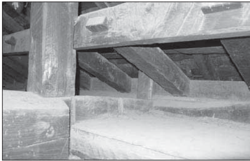
化粧垂木尻 垂木掛に柄差し固定状況
