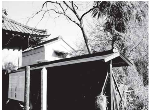
125 袖塀屋根塗装
