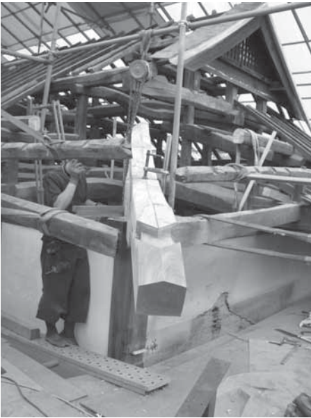
6 1 南東隅木設置
