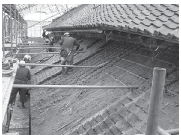
38 背面下屋瓦解体
