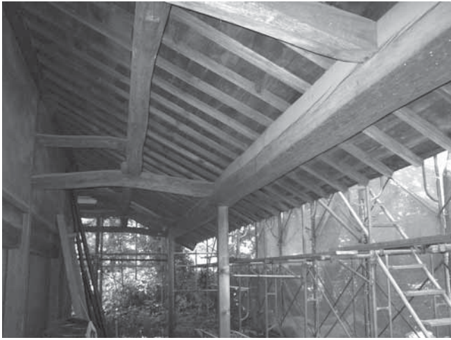
73 下屋修理完了
