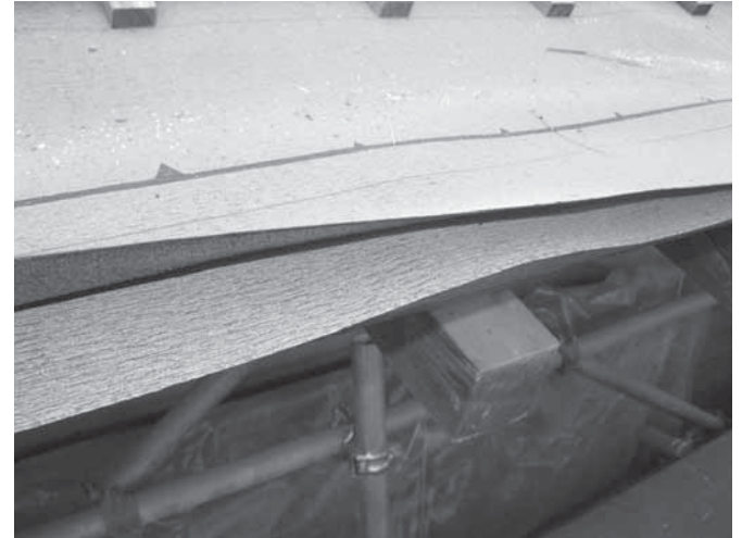
76 ルフイング二重張り
