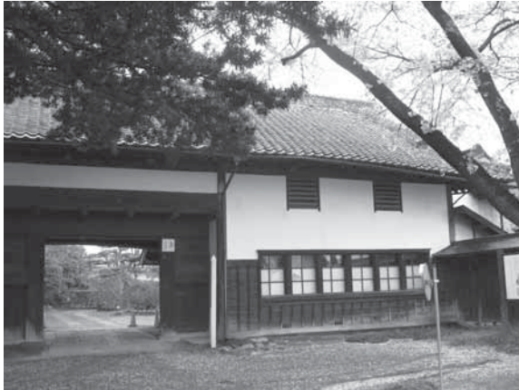
11 修理前 正面写真
