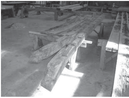
25 茅負腐朽状況
