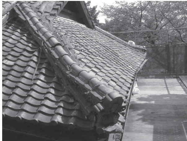
18 修理前 北西隅
