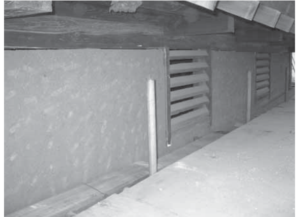
117 既存喰壁掻き落し
