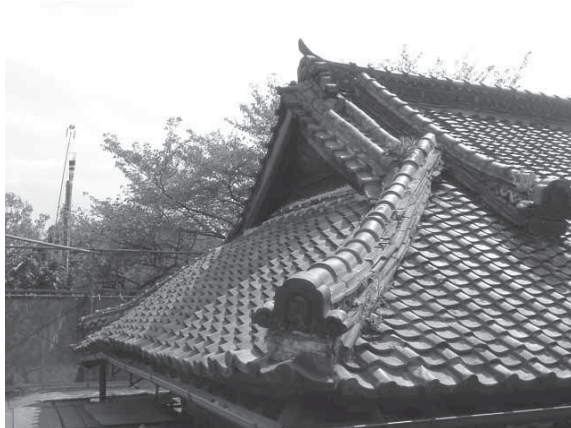
15 修理前 北西棟廻り
