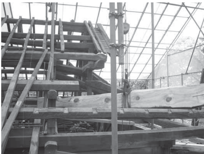
57 隅木吊り込み
