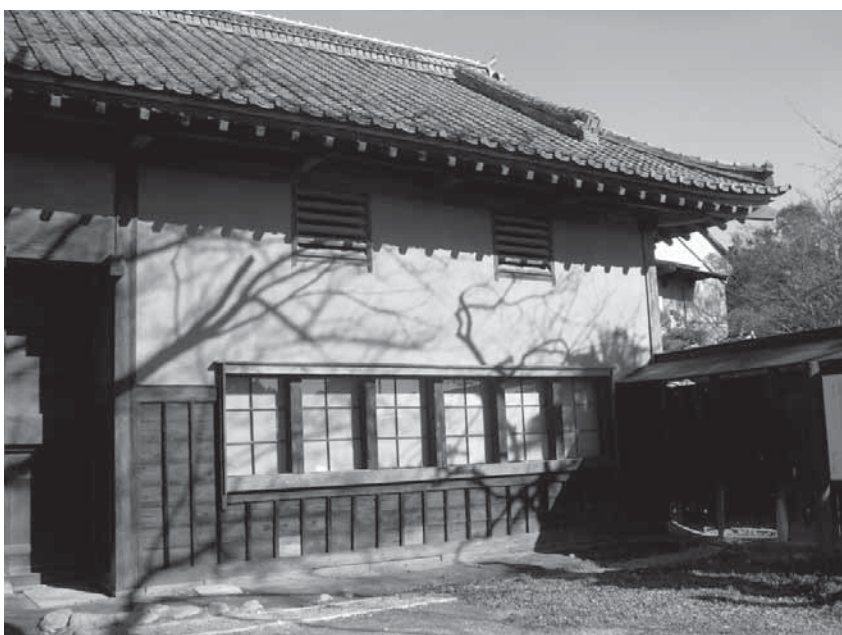
3 竣工 正面東側写真
