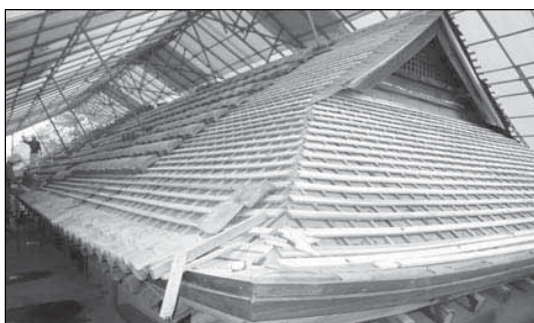
長屋門屋根 空葺き施工状況
