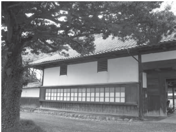
13 修理前 正面東側写真
