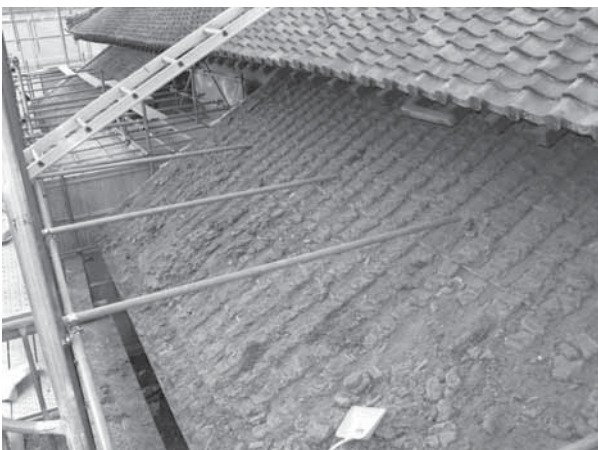
39 背面下屋瓦解体
