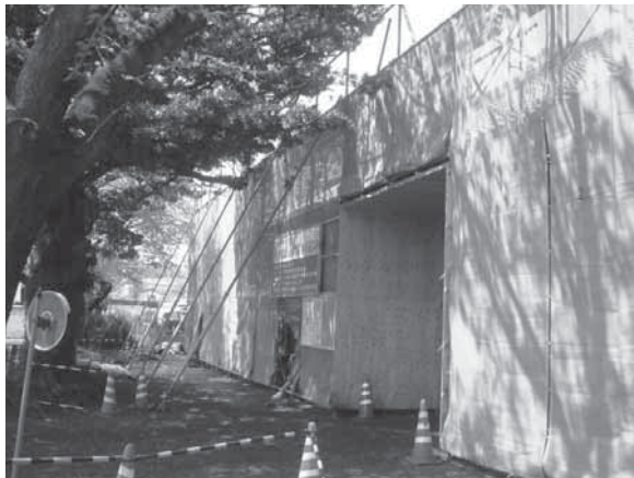
29 周囲シート養生
