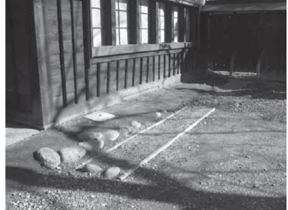
113 正面東側雨落ち溝
