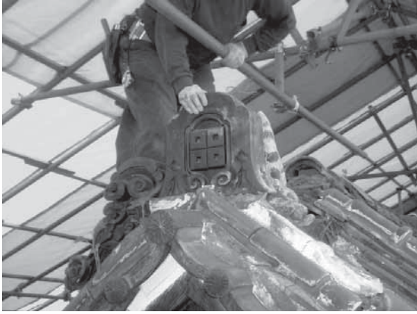
41 大棟鬼瓦解体
