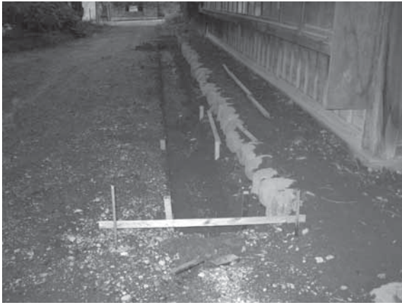
110 雨落ち溝施工
