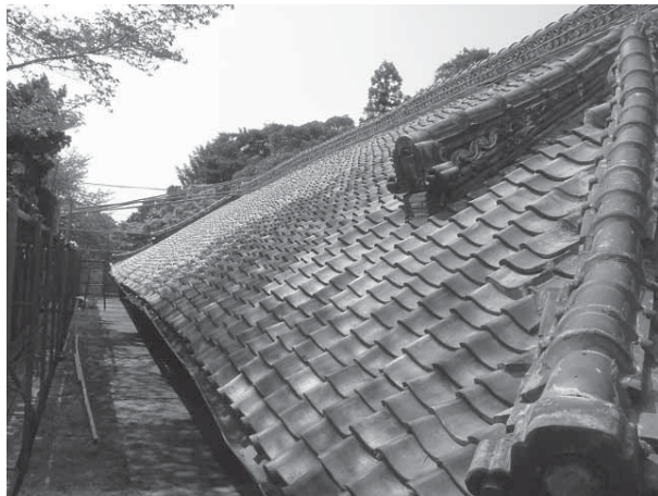
17 修理前 南東隅
