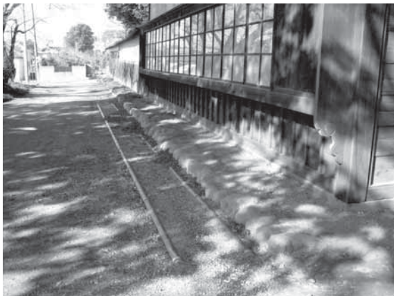
112 正面西側雨落ち溝
