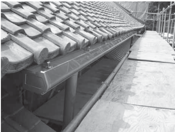
122 背面軒樋取付け
