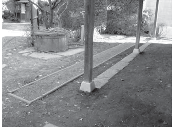
115 背面東側雨落ち溝
