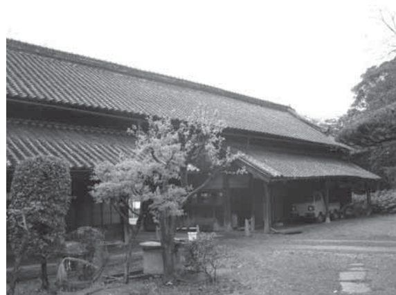
14 修理前 背面写真
