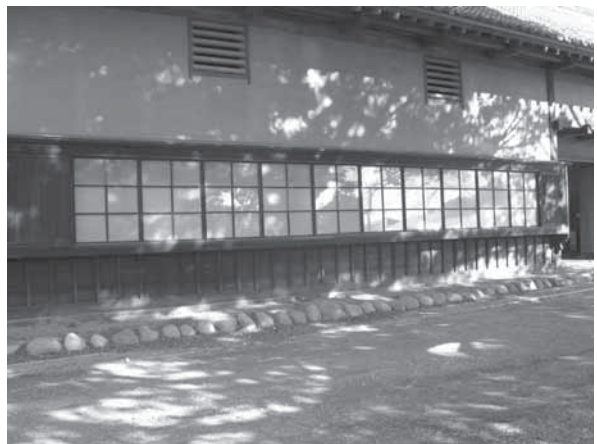
123 すりガラス設置
