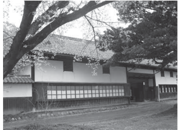
12 修理前 正面西側写真
