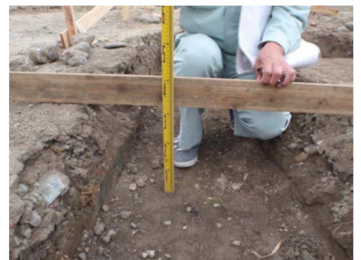
工事立会での測量(熊谷市上之地内)
