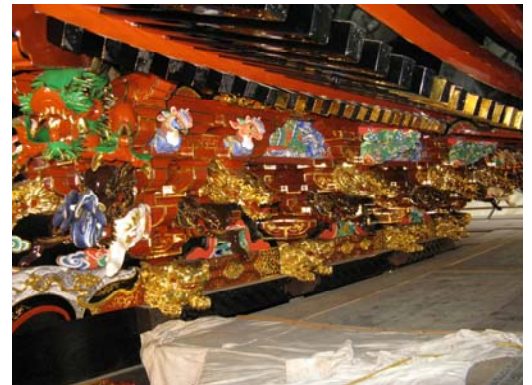
修理が終了した本殿軒下の彫刻と彩色
