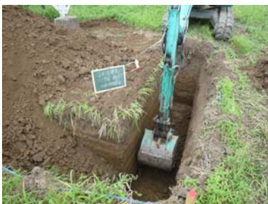
溝（トレンチ）を掘る
